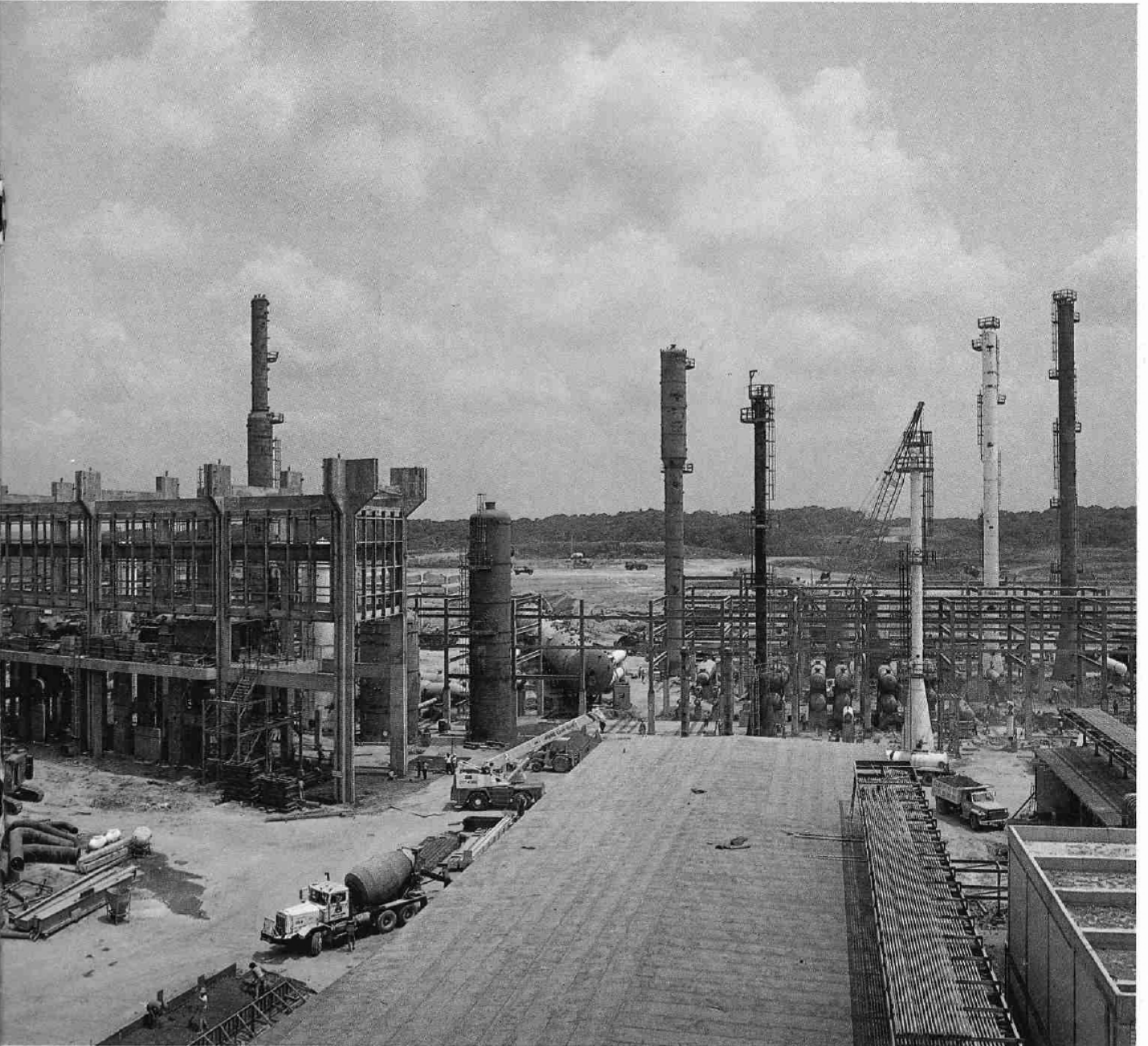
Vista general de las diversas estructuras e instalaciones que construye ICA Industrial dentro del Complejo Petroquímico Morelos, en el estado de Veracruz.
