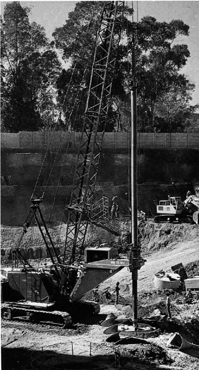
Perforación para pilas de gran diámetro.
