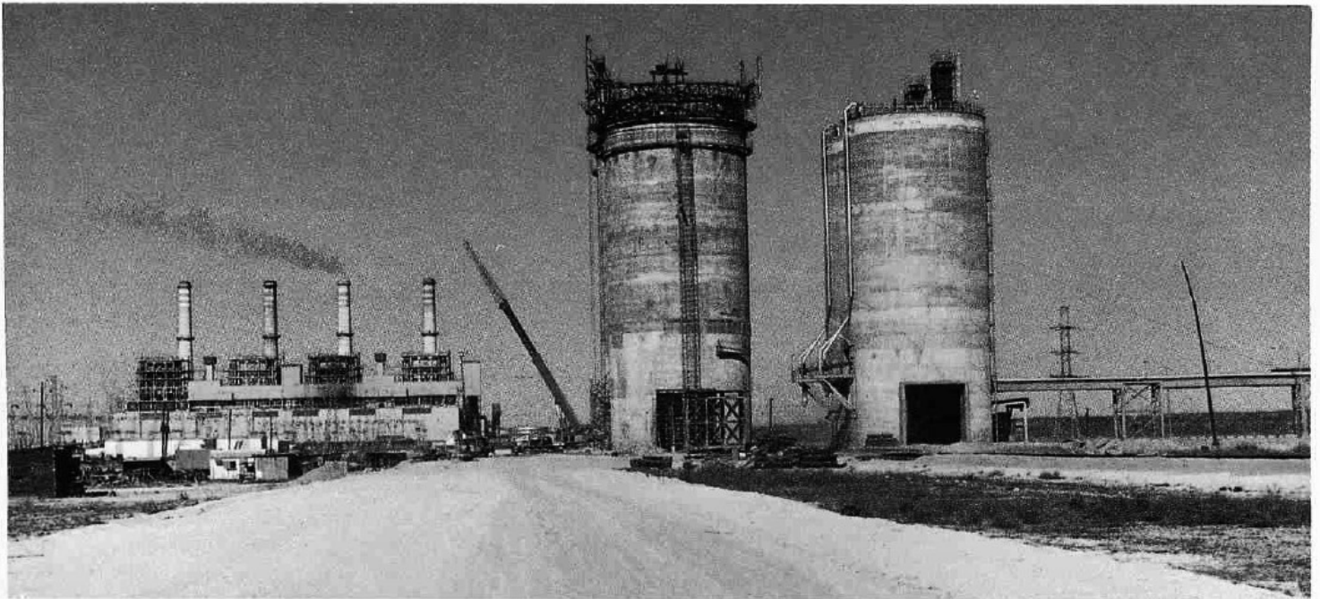
Otro aspecto de los silos en construcción, al fondo a la izquierda la planta termoeléctrica Río Escondido, Coahuila.
